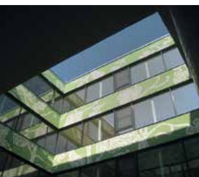
Fassade Weinlaub NÖ Pflege- und Betreuungszentrum Wolkersdorf
